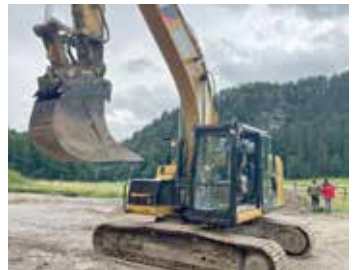
Die Arbeiten mit dem Bagger sind zu Ende - Zeit für den Innenausbau.
