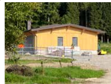
Der Neubau steht kurz vor der Fertigstellung.
