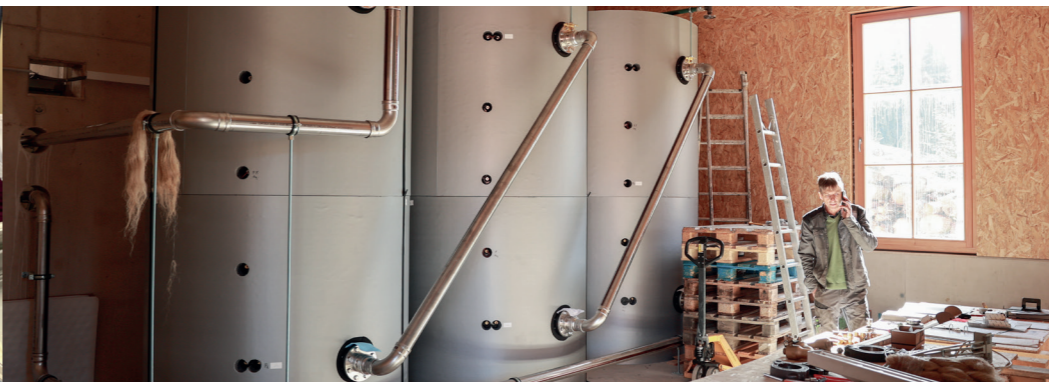
In der ersten Novemberwoche 2025 ist die Hackschnitzelheizung mit 320 KW erfolgreich in Betrieb gegangen. Die Pufferspeicher, hier im Bild, sorgen für konstanten Kesselbetrieb und Wärmeverteilung.
